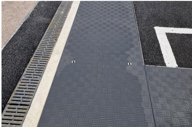
الجدير بالذكر أن أغطية فيبرلايت "Fibrelite" تتميز بمقاومة عالية للتآكل، فهي لا تتأثر بالمياه ولا بالغازات الموجودة تحت الأرض ولا بمعظم المواد الكيميائية
