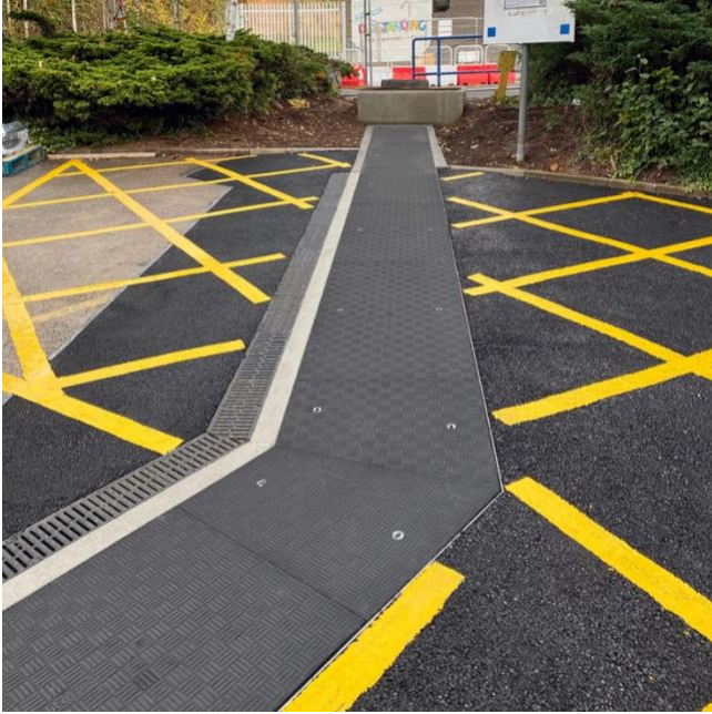
اخترت شركة هيلتون بوديل "Hilton Bodill" للإنشاءات أغطية فيبرلايت وخطوط أنابيب KPS لتجديد مستشفى مدينة نوتنغهام
