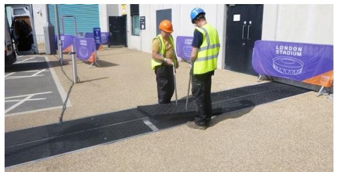
يمكن إزالة أغطية الخنادق المركبة من فيبرلايت "Fibrelite" يدوياً من قبل شخصين باستخدام مقابض الرفع FL7 من فيبرلايت (كما هو موضح في الصورة المرفقة على موقع آخر)
