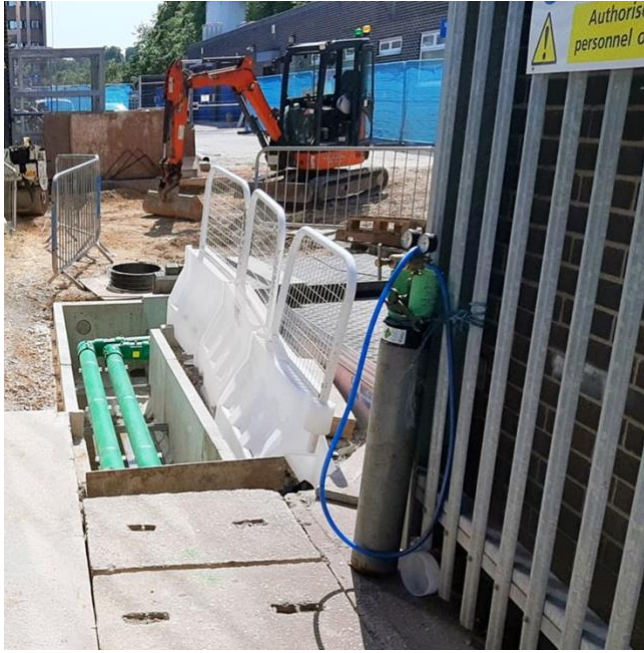
بالإضافة إلى ذلك، كانت أغطية الوصول الخرسانية السابقة تشكل تحديًا بسبب وزنها الثقيل الذي يعيق عملية إزالتها وتركيبها
