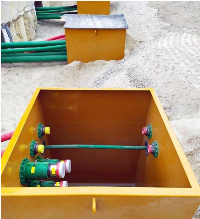
تتميز أنابيب KPS قياس 4 بوصة بقدرتها على تحقيق معدل تدفق يصل إلى 933 لتراً في الدقيقة، مما يوفر عملية تزويد سريعة بالوقود.
