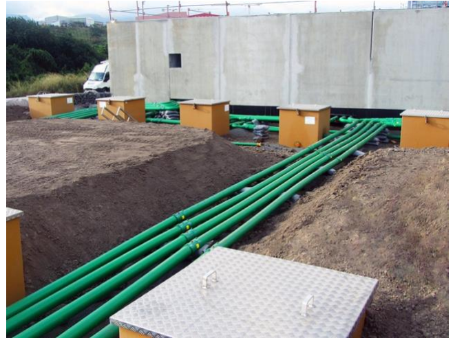
تتميز أنابيب KPS بأنها آمنة ضد الكهرباء الساكنة، مما يقلل من مخاطر تراكم الشحنات الكهربائية
