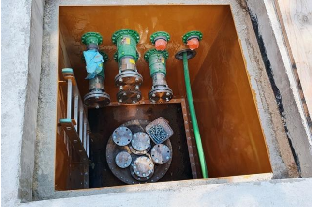
وفرت شركة KPS حلاً مانعاً للتسرب، وكذلك أغطية محكمة الإغلاق ضد دخول الماء.
