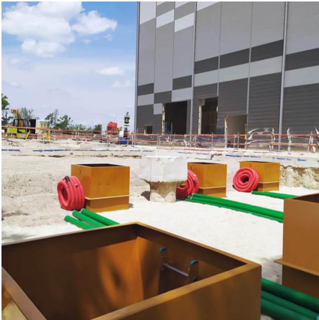
تربط الأنابيب الموصلة KPS ذات الجدار المزدوج بقطر 2 بوصة (63/75 مم) خزانات الوقود بالمولدات الاحتياطية.
