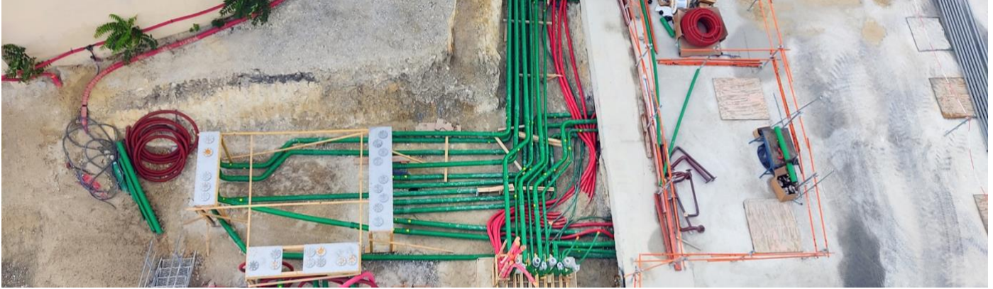
ذات الجدار المزدوج عالية الأداء لضمان تزويد المولدات الاحتياطية بالوقود KPS اختار مركز بيانات جديد في باريس أنابيب
