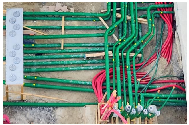
بفضل خاصية التوصيل الكهربائي، تمنع أنابيب التوصيل من KPS تراكم الكهرباء الساكنة.
