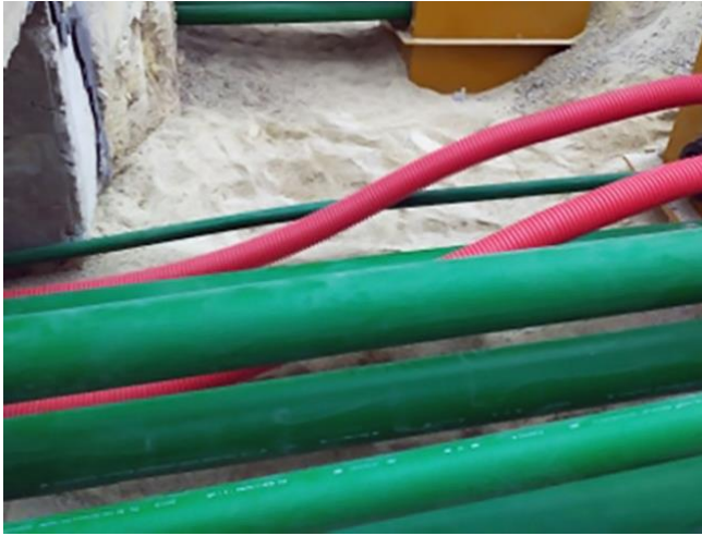
تتميز أنابيب KPS بعدم نفاذ السوائل تماماً (لا تسمح بتسرب السوائل/الماء).
