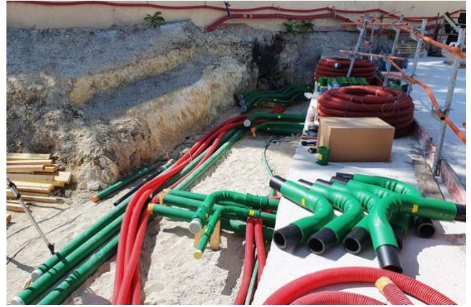
توفر الأنابيب ذات الجدار المزدوج من KPS طبقة إضافية من الحماية بسبب وجود مساحة فاصلة بين الأنبوبين الداخلي والخارجي.
