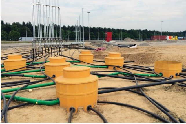
تتميز أنظمة غرف فايبرلايت "Fibrelite" بأنها قابلة للاختبار الكامل بالتفريغ ومحكمة الإغلاق ضد تسريبات الماء.
