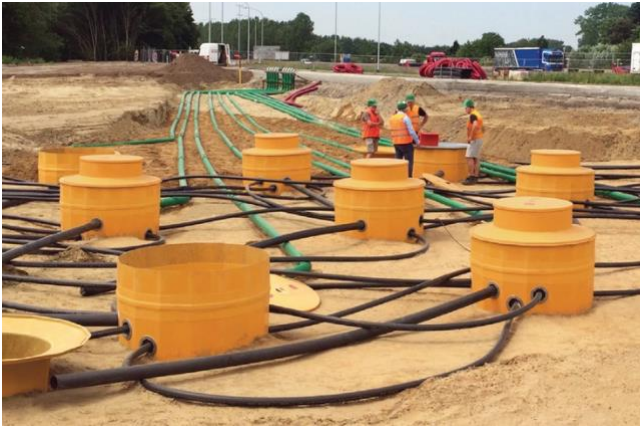
قلّلت أحواض فيبرلايت "Fibrelite" وأنابيب KPS من وقت التركيب.
